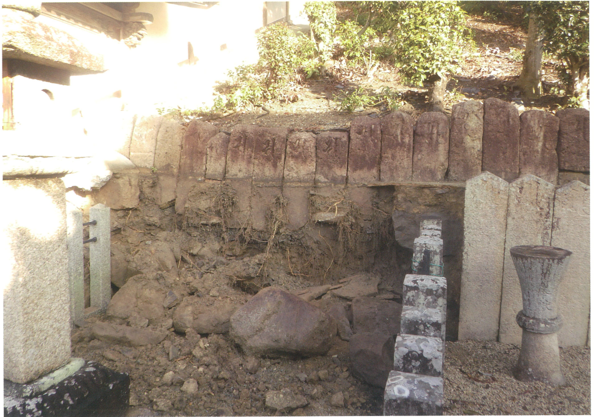
1 東区 石積崩落状況（南から）
