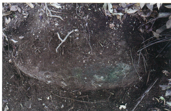
4 西北西部 地覆石 (C地点) 上から
