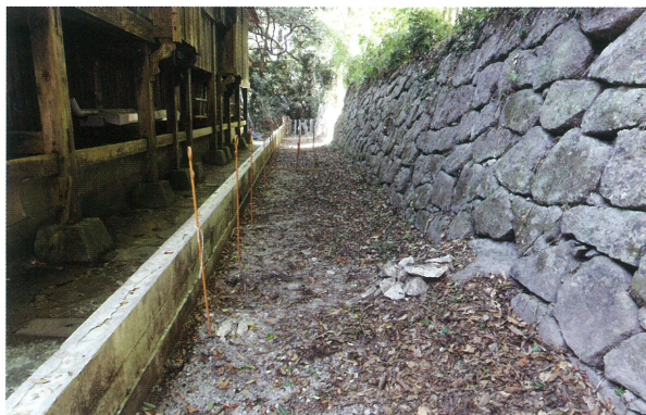
1 掘削前写真（東から）
