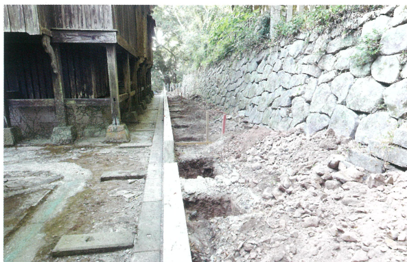
2 掘削後写真（東から）
