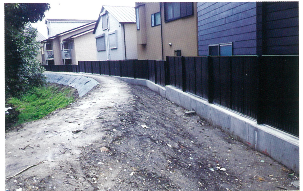
6 工事後 境界標識15号付近（北から）
