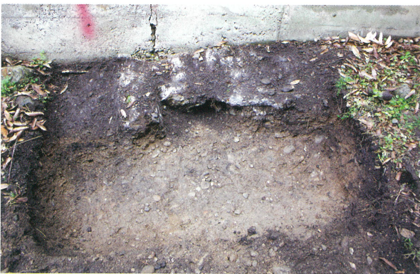
5 北側掘削箇所 B 地点 (南から)
