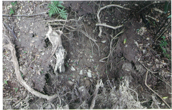
2 根起き箇所 倒木の上から（調査前）
