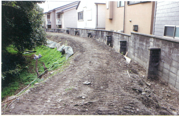
1 境界標識 15 号付近 (北から)
