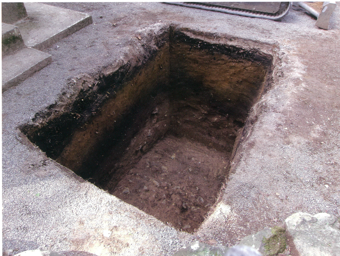
1 新規浄化槽設置箇所 北壁・東壁（南西から）
