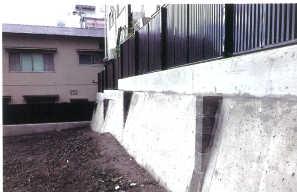
7 工事後 境界標識18号付近（東から）
