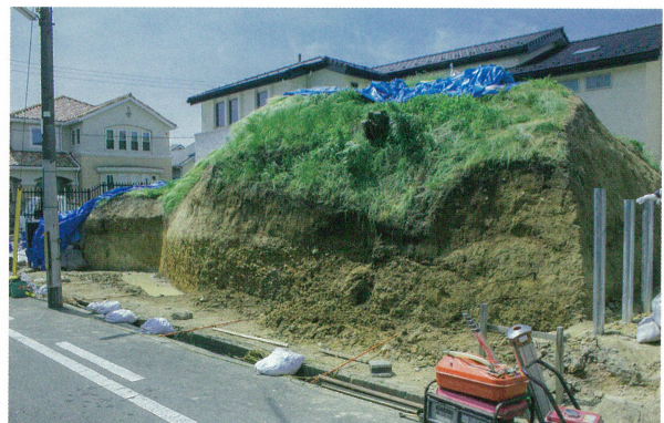
3 南壁（北西から）
