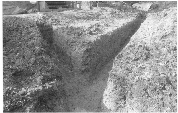
4 第2トレンチ 西壁（南から）
