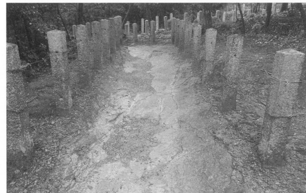
5 日岡陵参道岩盤露出状況（拝所南方）
