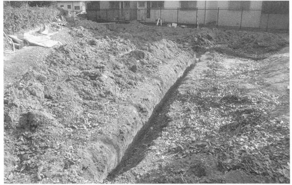
2 第1～7トレンチ 掘削状況（北西から）
