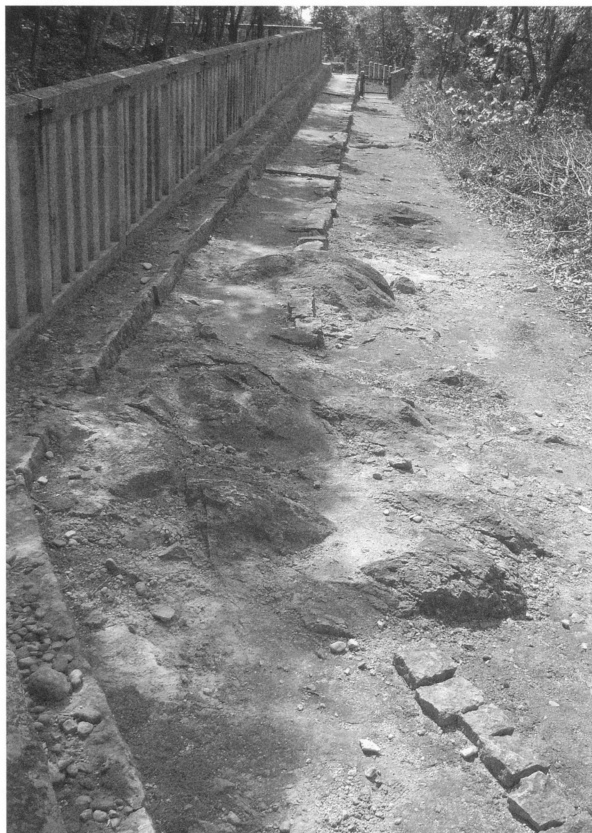
5 北西側くびれ部 岩盤露出状況 (2) (北から)
