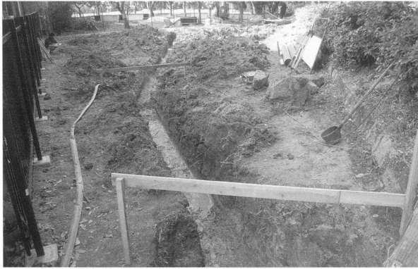
1 第1～7トレンチ 掘削状況（東から）
