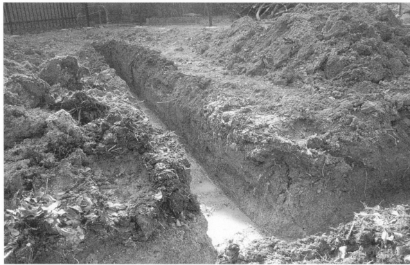
3 第5トレンチ 西壁（北から）
