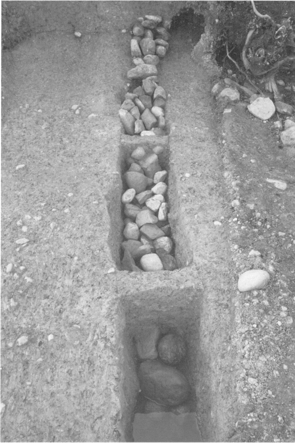
1 第7トレンチ排水溝（東から）
